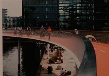
Fietsbrug over de A10
